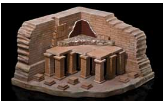
2 Modell einer römischen Fußbodenheizung
